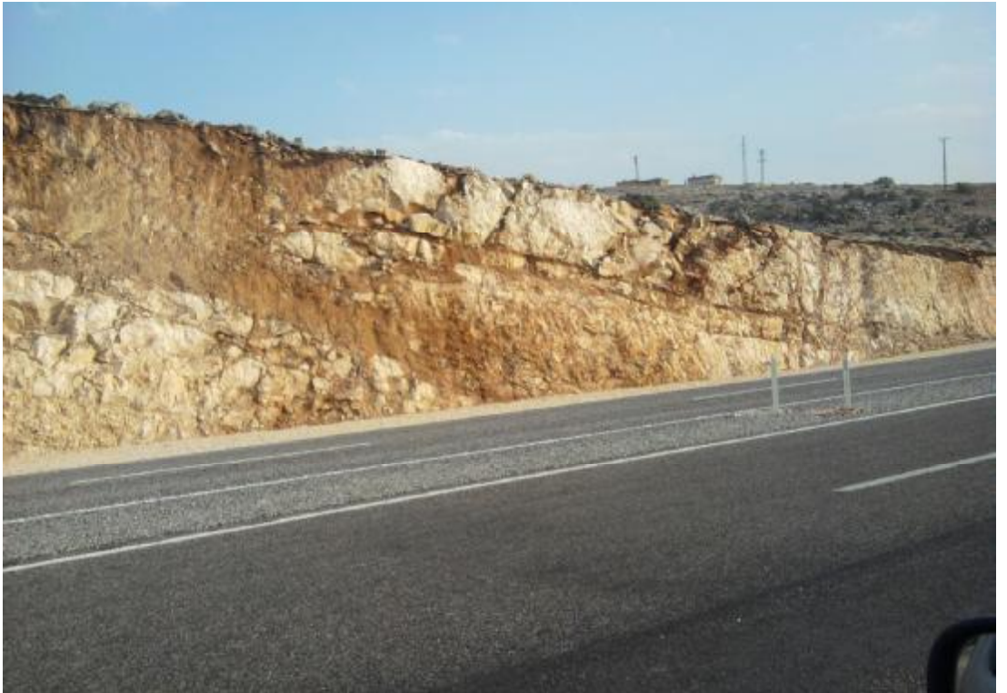
Şekil 3.8. Çalışma alanında yol yarması.
