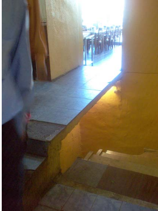
Resim 4.66. Bodrum kata inen servis merdiveni.
