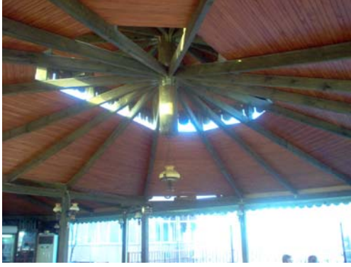
Resim 4.95. Mekana yapılan ahşap ek bina.
