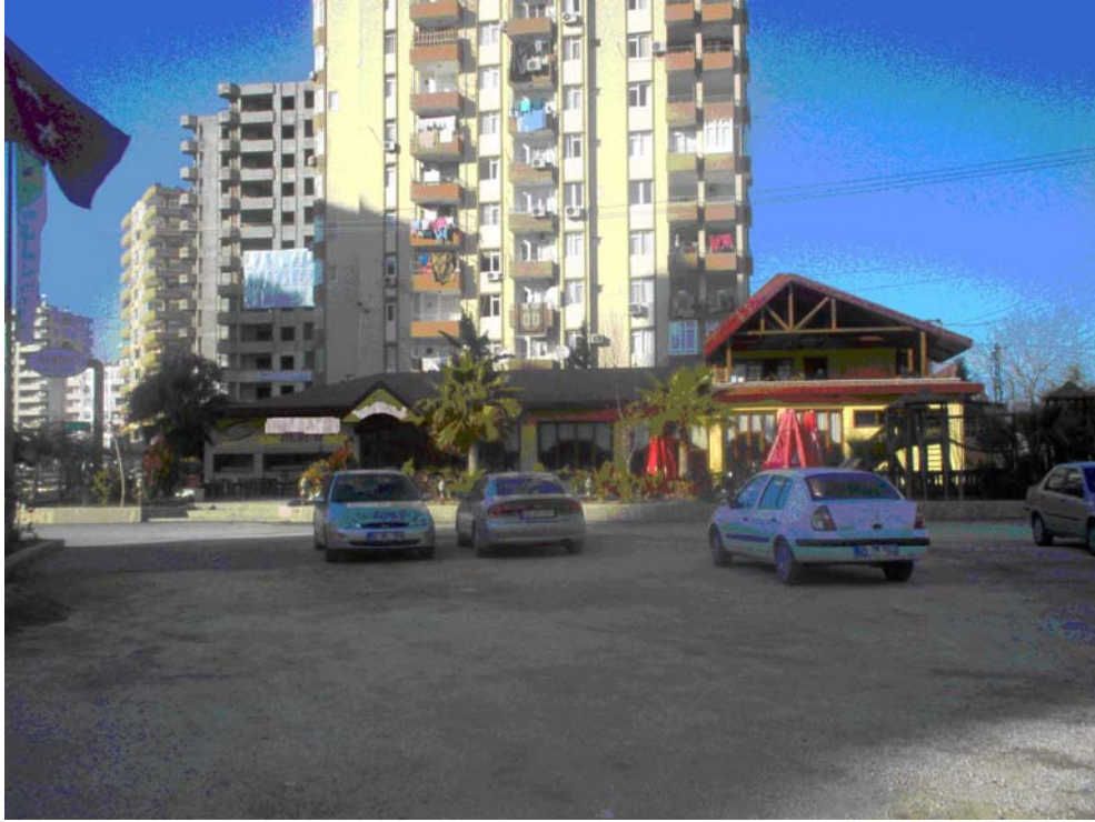
Resim 4.72. Örnek 22'nin giriş cephesi.
