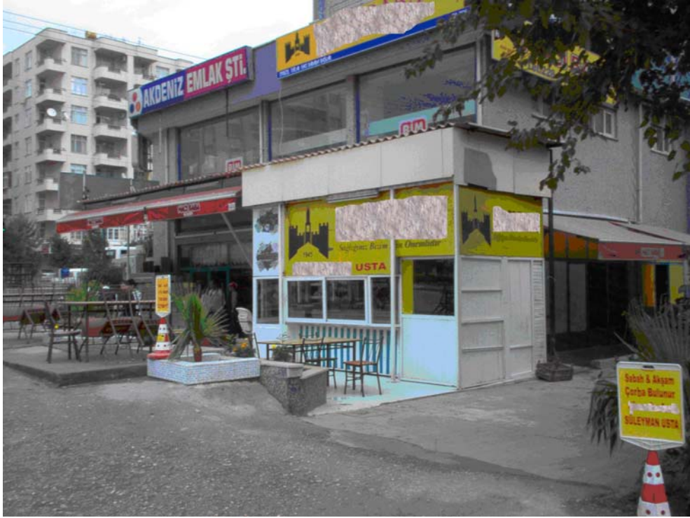
Resim 4.54. Örnek 17'nin giriş cephesi.
