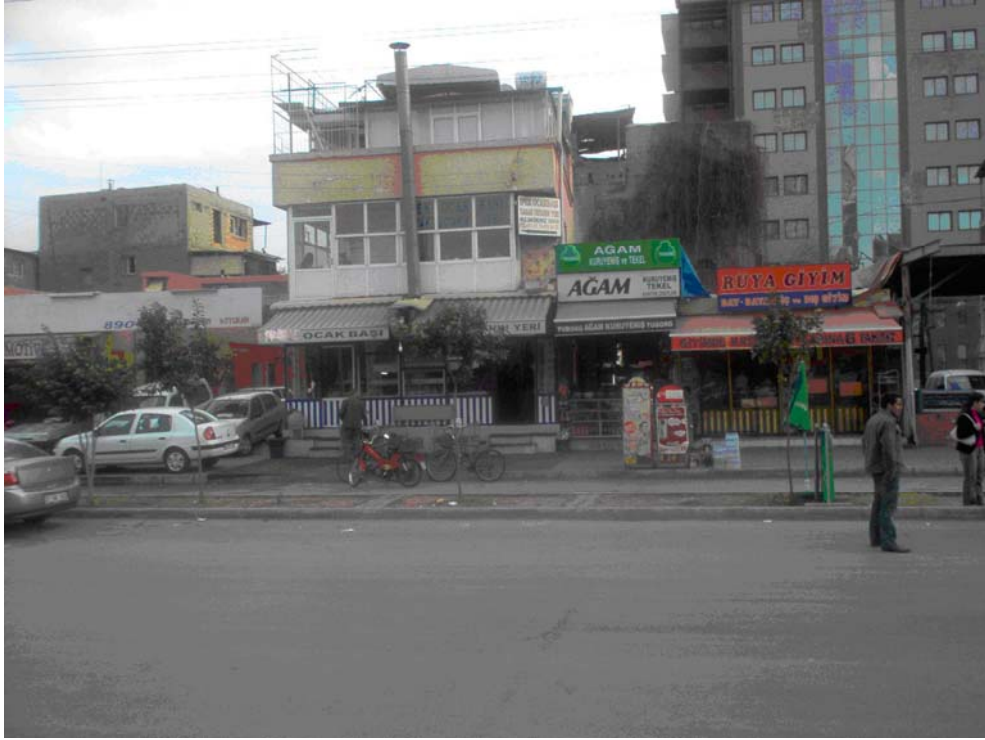
Resim 4.39. Örnek 12'nin giriş cephesi.
