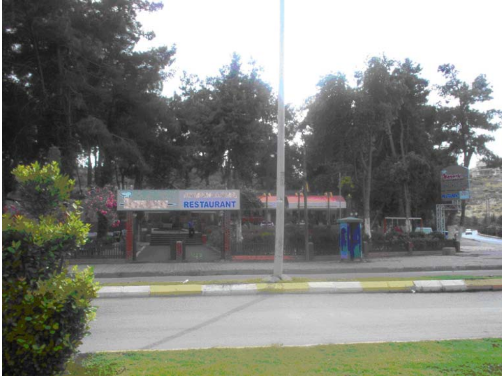
Resim 4.90. Örnek 27'nin giriş cephesi.
