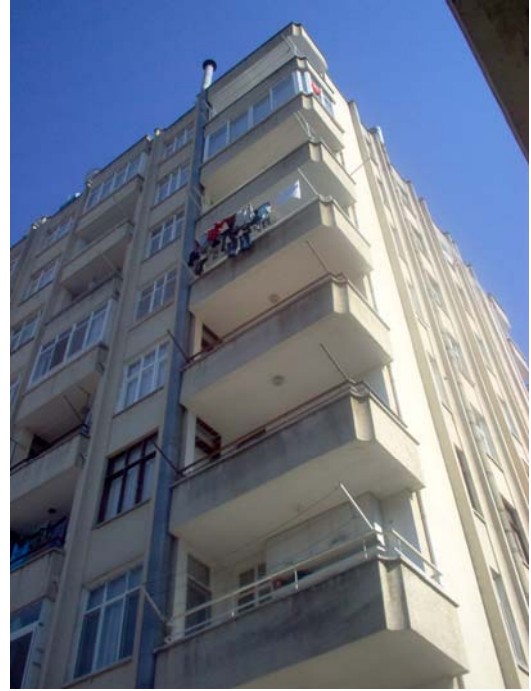
Resim 4.84. Mutfaktan çıkan baca ve cephedeki görüntüsü.
