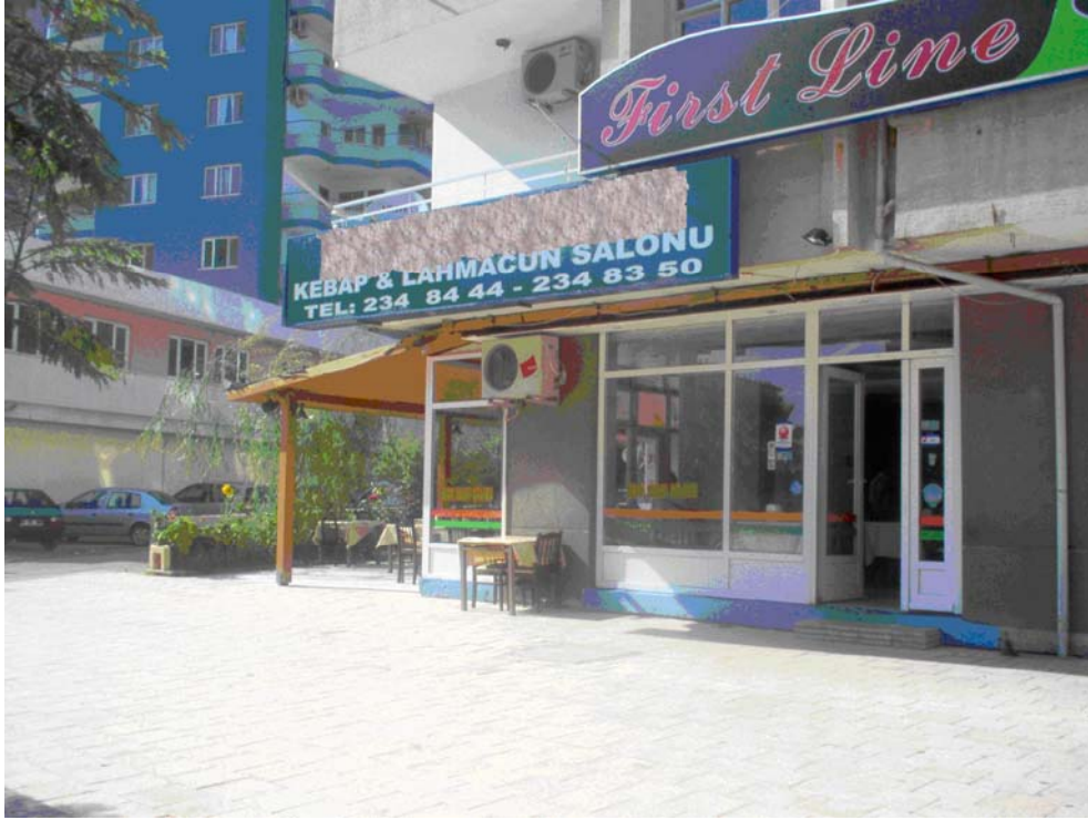
Resim 4.82. Örnek 25'in giriş cephesi.
