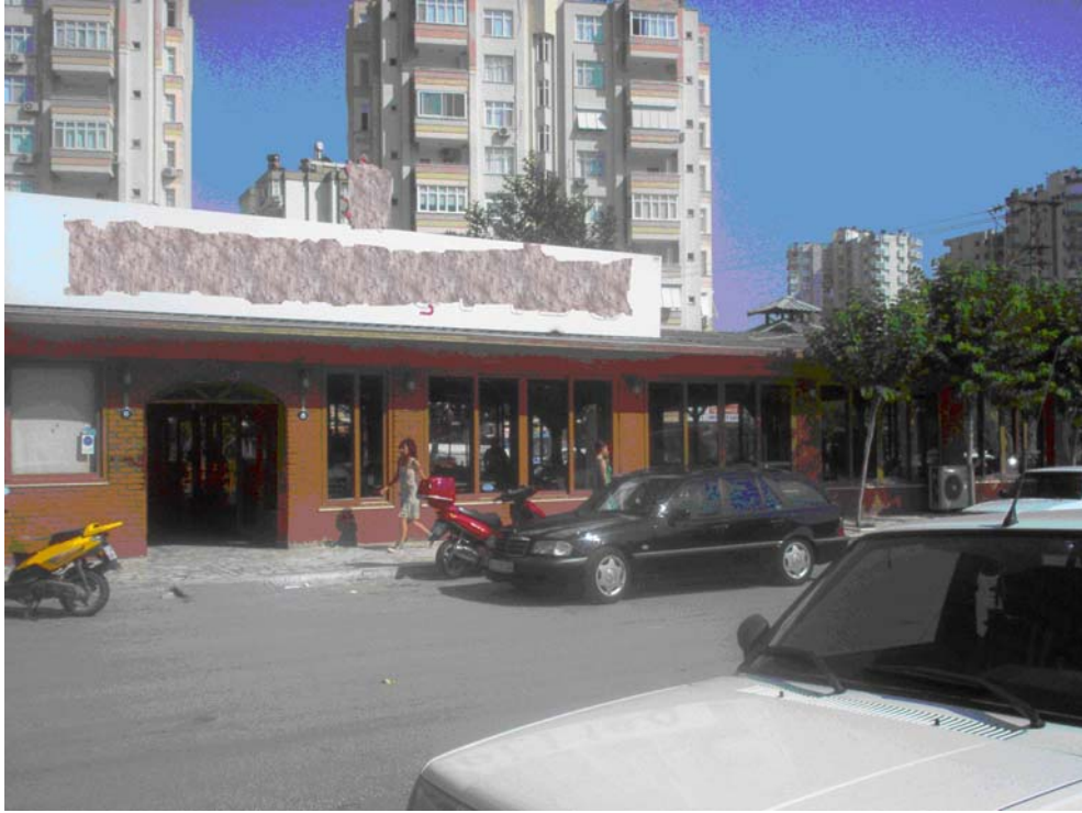
Resim 4.59. Örnek 18'in giriş cephesi.
