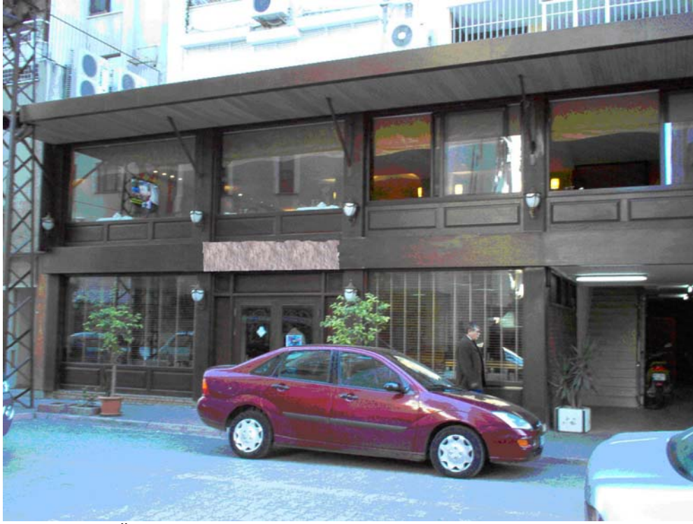
Resim 4.26. Örnek 7'nin giriş cephesi.
