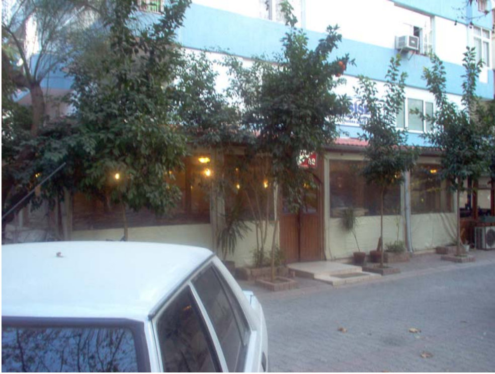
Resim 4.28. Örnek 8'in giriş cephesi.
