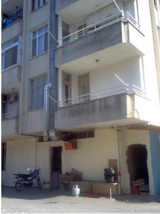
Resim 4.84. Mutfaktan çıkan baca ve cephedeki görüntüsü.
