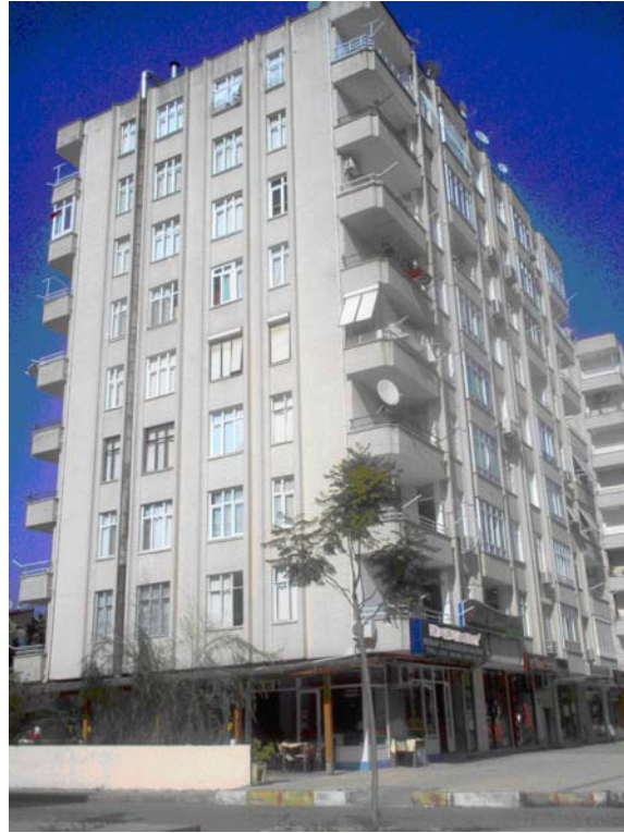
Resim 4.83. Apartman cephesinde borunun görünüşü.
