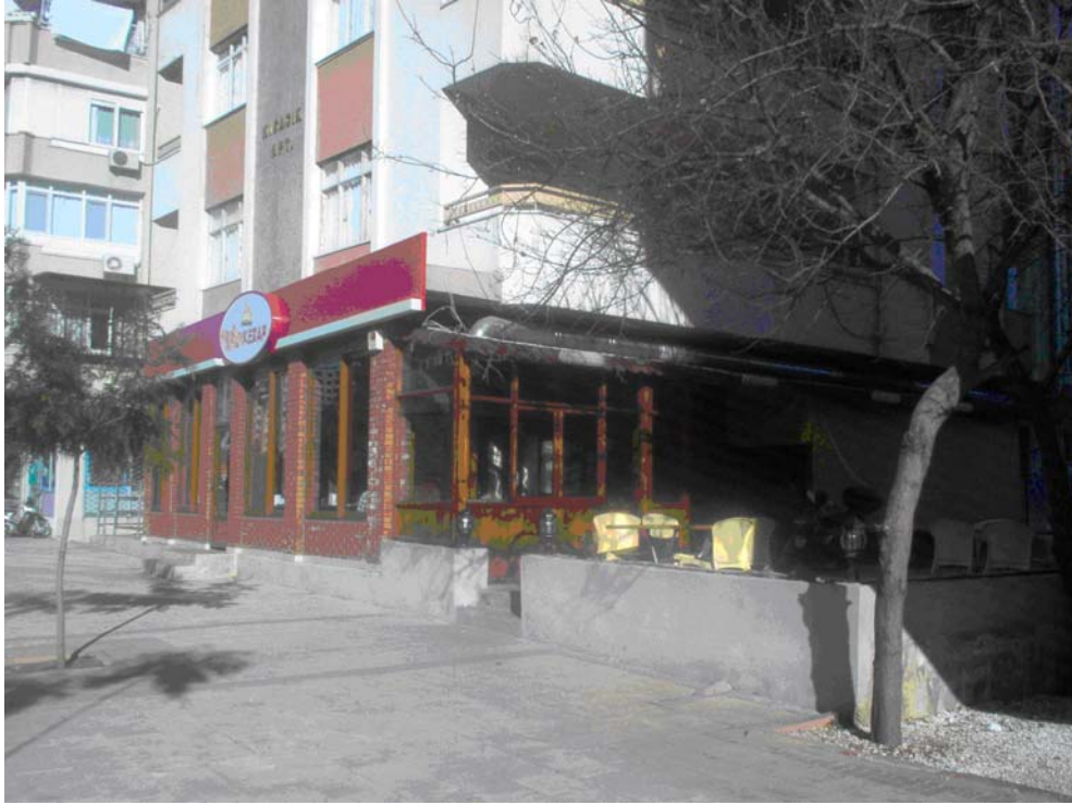
Resim 4.67. Örnek 20'nin giriş cephesi.
