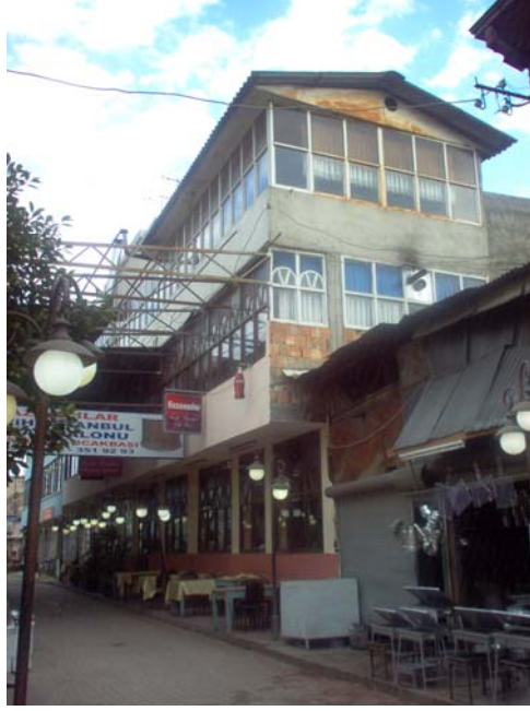
Resim 4.2. Örnek 1'in giriş cephesi.
