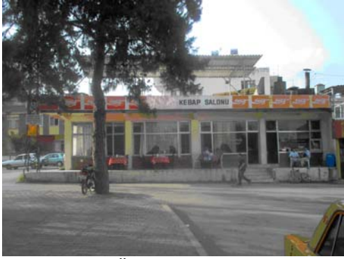
Resim 4.48. Örnek 15'in giriş cephesi.
