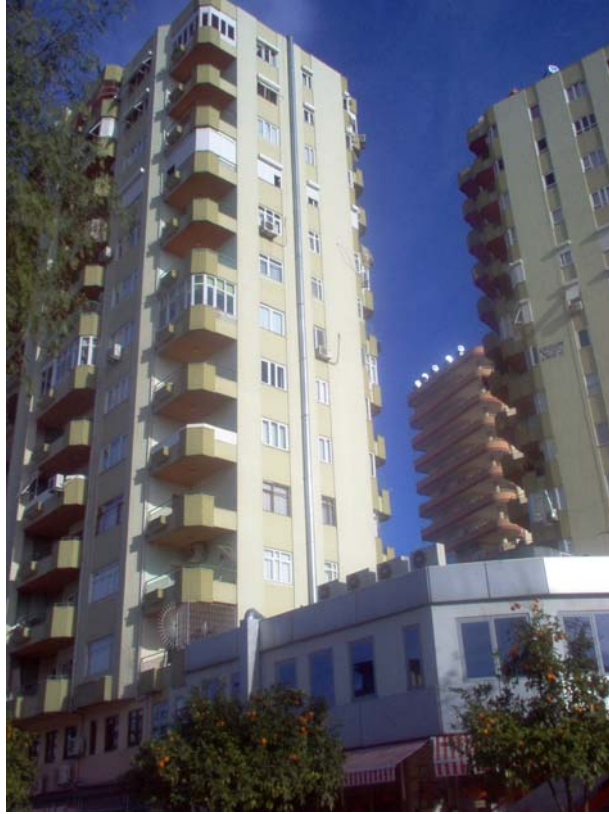
Resim 4.44. Apartmanın cephesi boyunca giden boru.
