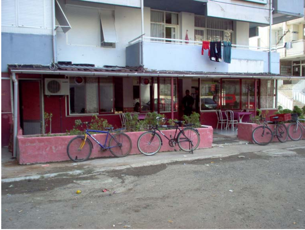
Resim 4.52. Örnek 16'nın giriş cephesi.
