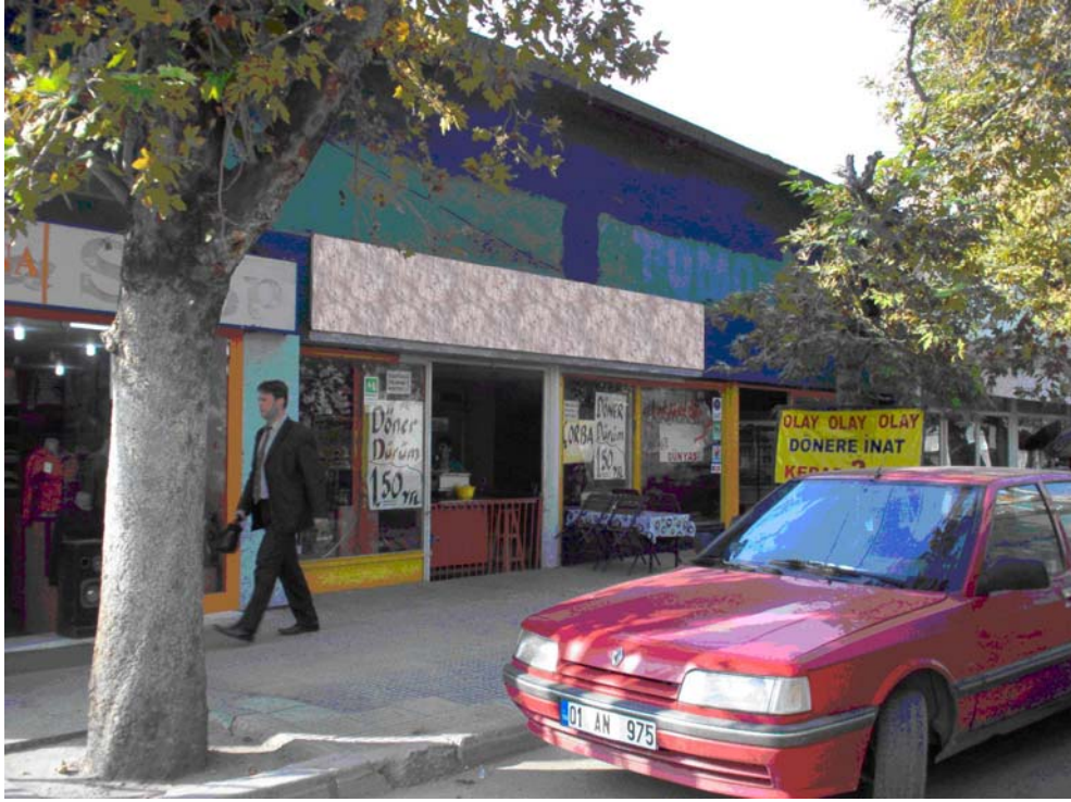
Resim 4.10. Örnek 2'nin giriş cephesi.
