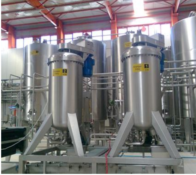
Şekil 3.4. Kizelgur filtre ünitesi
