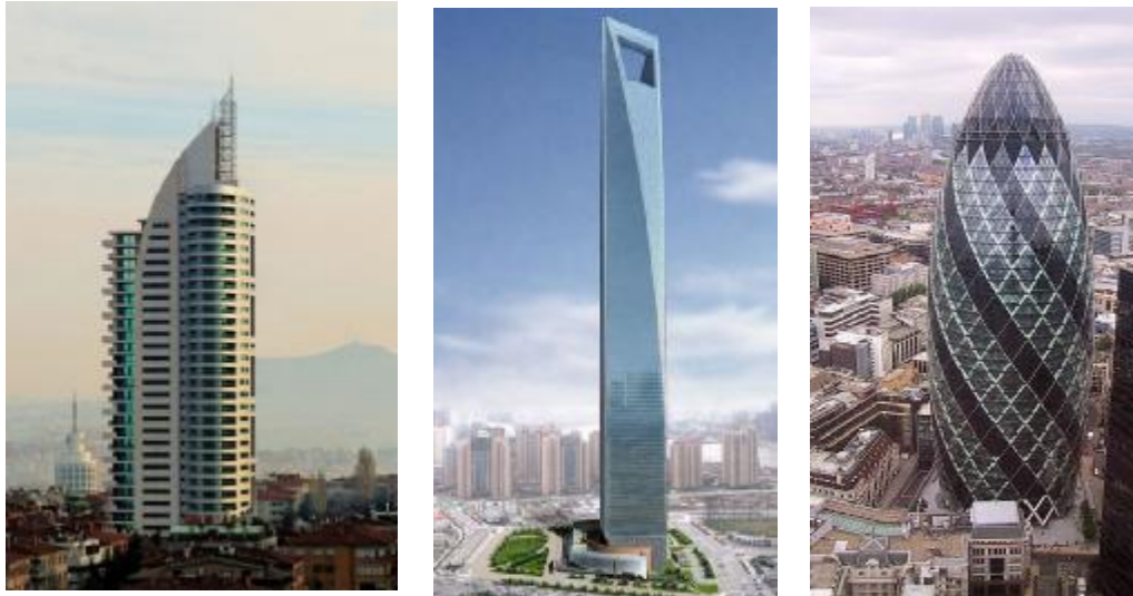
Resim 4.1. (a). Portakal Konut Kulesi (b). The Shanghai World Financial Center Binası (c).Swiss Re
