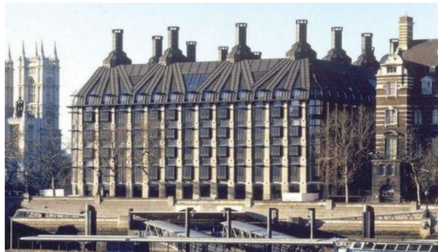
Resim 4.4. Portcullis Yeni Parlamento Binası doğal havalandırma sağlayan rüzgar bacaları
