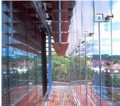
Resim 4.3. Glaso Welcome Binasının Çift cam uygulaması
