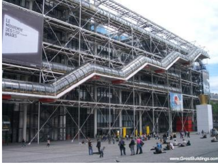
Şekil 4.21. Pompidou merkezi ( www.greatbuildings.com , 2009)
