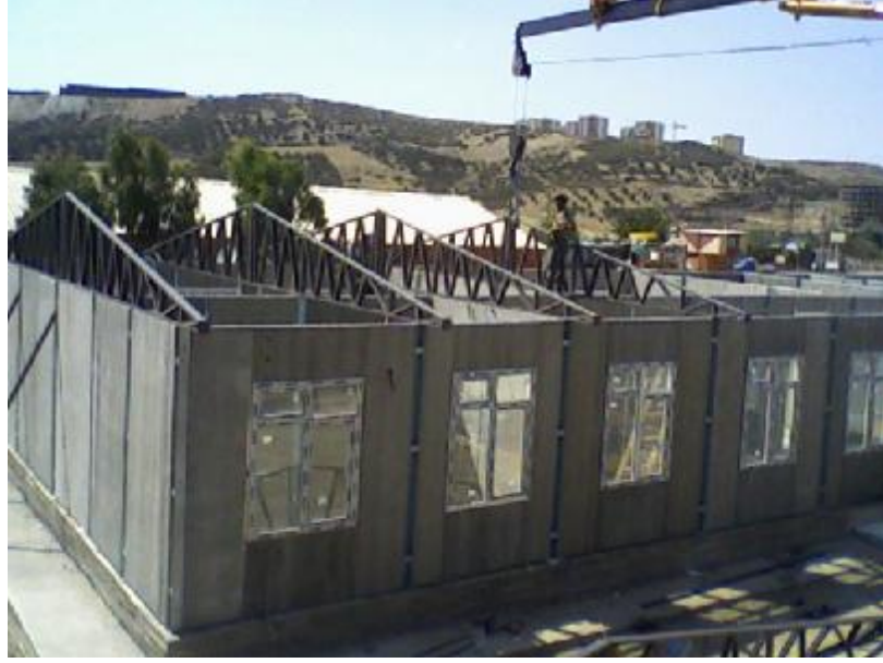
Şekil 4.77. Bina yapım aşaması
