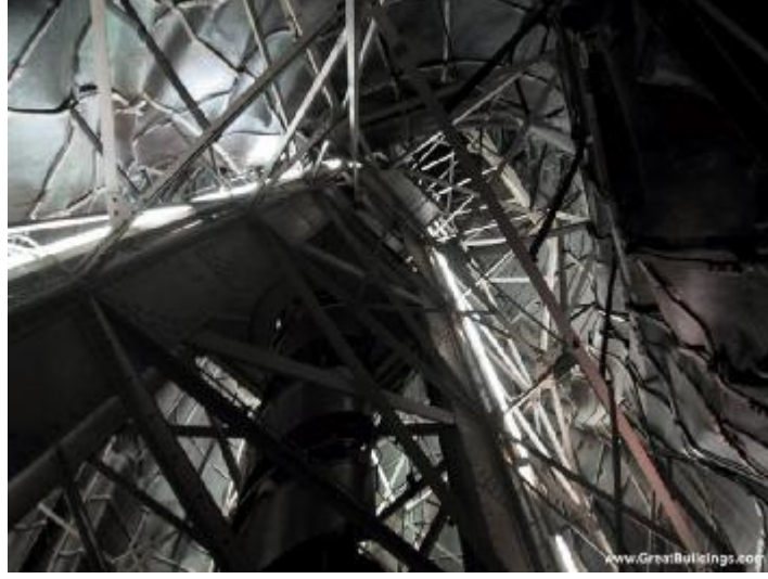
Şekil 4.11. Özgürlük Heykeli'nin iç çapraz kirişleri (www.greatbuildings.com, 2009)
