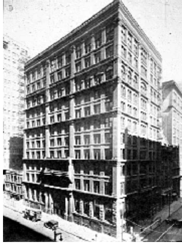
Şekil 4.13. Home Insurance Binası (Deren,2003)
