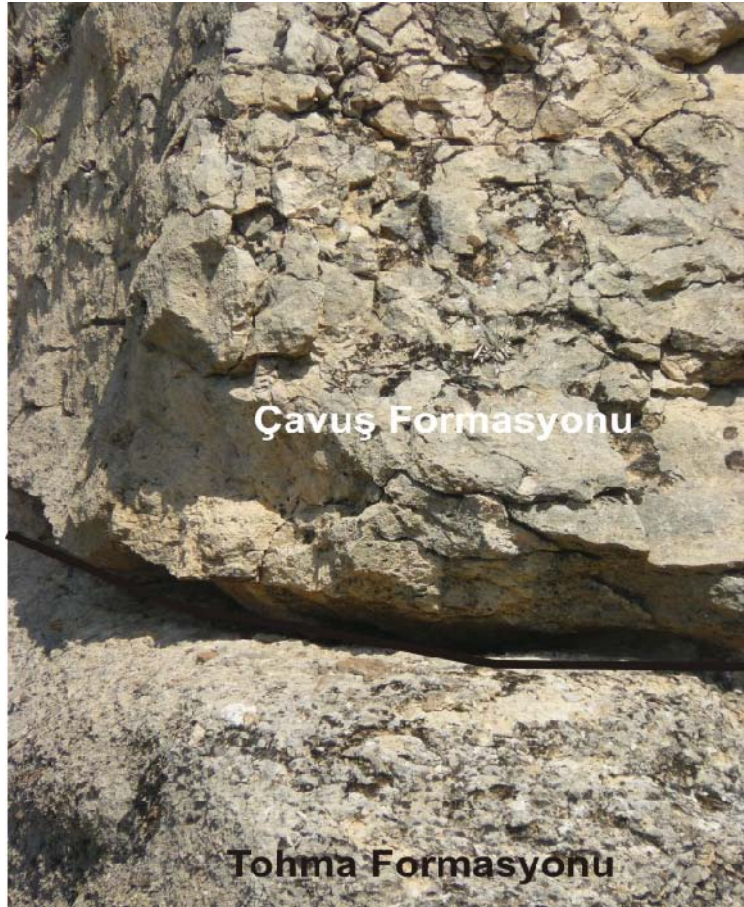
ekil 4.50. Çavu formasyonunun tabanındaki çakılta larının görünümü.
