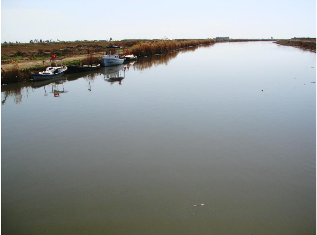
Resim 3.4. TD0 Drenaj Kanalı 1+85. Km
