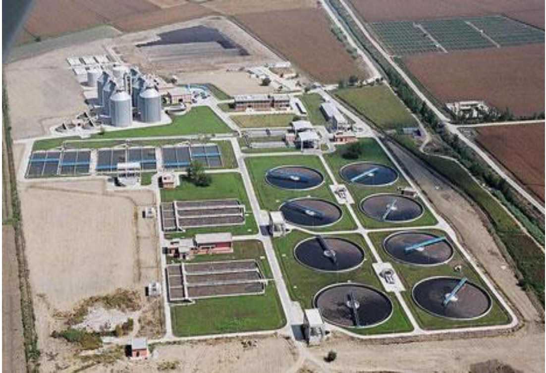
Şekil 3.6. Adana Batı Atıksu Arıtma Tesisinin Görünüşü (ASKİ, 1999)
