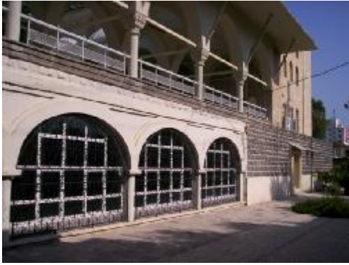
Resim 4.212.Bodrum Kat (Batı Cephesi)
