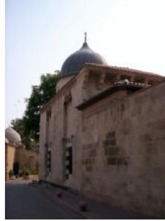
Resim 4.103. Türbe ve Kubbesi
