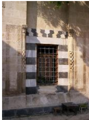
Resim 4.107. Güney Cephesindeki Pencere
