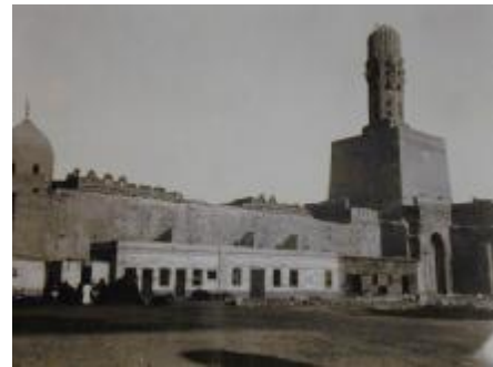
Resim 4.12.Avludan Kuzey Köşesinin Görünümü (12)
