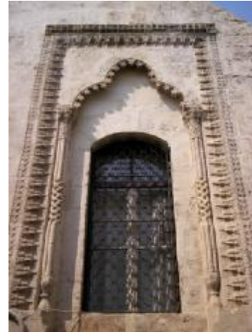
Resim 4.171. Güney Cephesindeki Pencere
