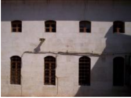
Resim 4.186. Batı Cephesi Pencere Dizisi
