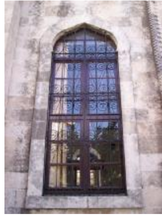
Resim 4.147. Sivri Kemerli Pencere
