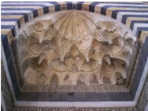
Resim 4.112.Doğu Taçkapısındaki Mukarnas
