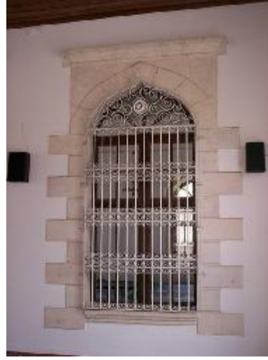
Resim 4.180.Sivri Kemerli Pencere
