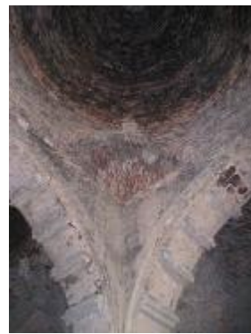
Resim 4.15. Köşe Trompu (15)
