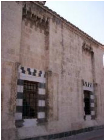
Resim 4.106. Doğu Cephesindeki Pencere
