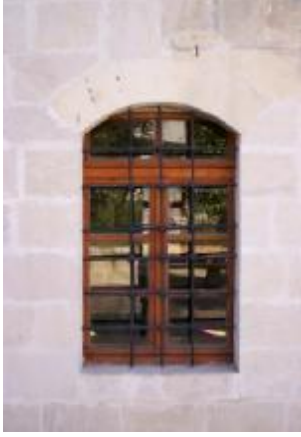
Resim 4.162.Doğu Cephesindeki Pencere
