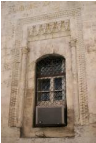
Resim 4.170. Doğu Cephesindeki Pencere
