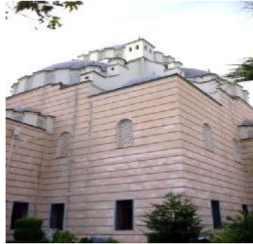
Resim 4.237. Eksedranın Dışarıdan Görünümü
