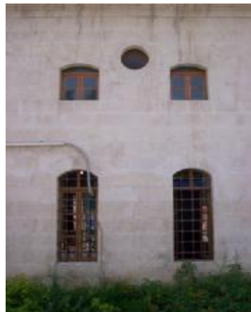
Resim 4.185. Giriş Cephesi Pencere Dizisi
