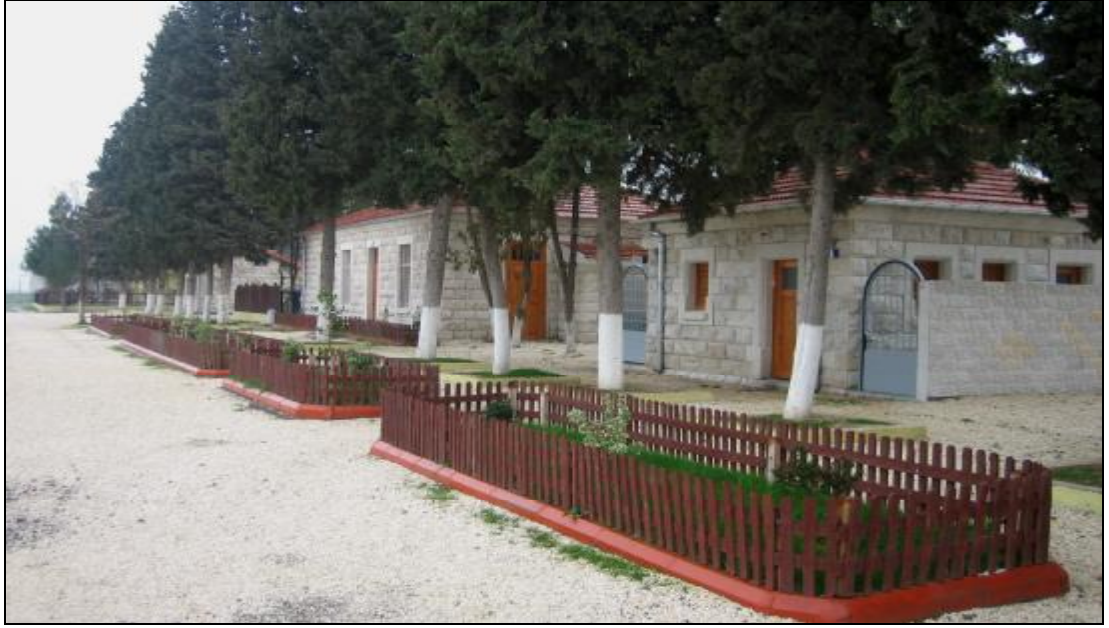
Şekil 4.51. Devlet Demiryolları 6. Bölge Müdürlüğü Lojmanları
