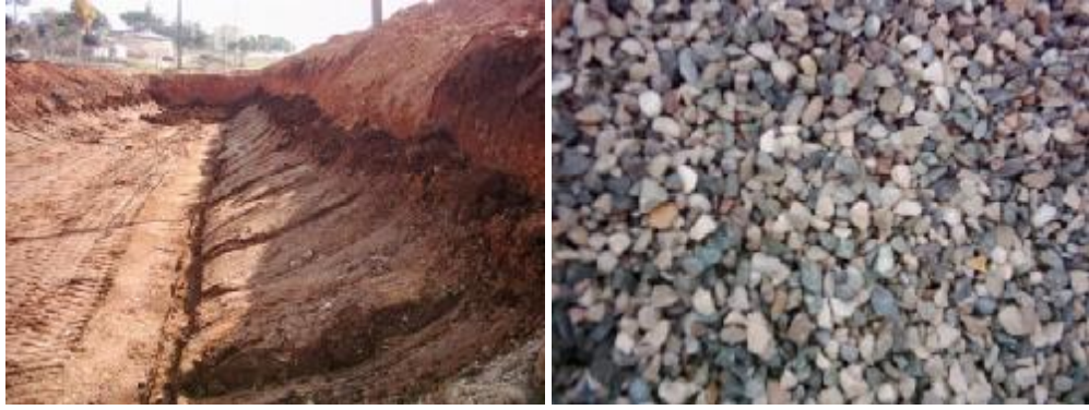
Şekil 3.3 Sulak alanın şevi, kil dokusu ve kullanılan çakıl malzeme
