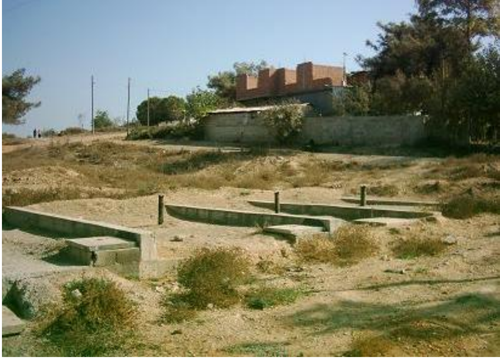
Şekil 3.1 Sulak alan öncesindeki dört gözlü foseptik
