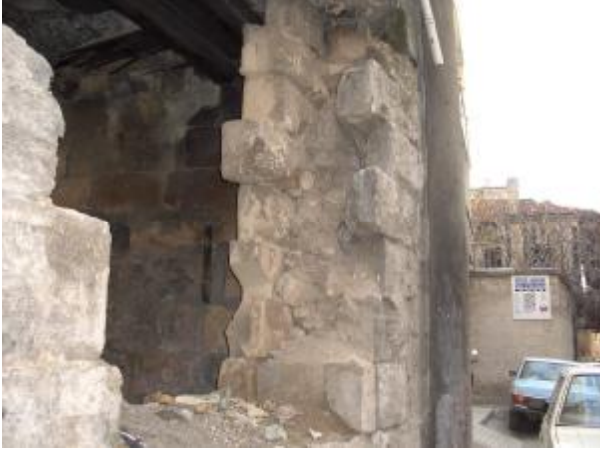
Şekil 4.7. Duvar detayı, 67 envanter nolu yapı
