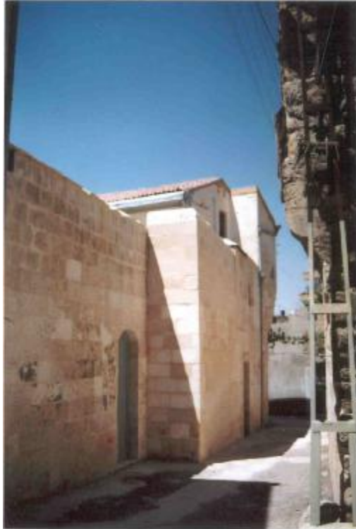
Şekil 4.108. Restorasyon sonrası sokak cephesi
