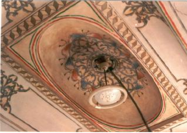
Şekil 4.37. Tekne tavan, 220 envanter nolu yapı
