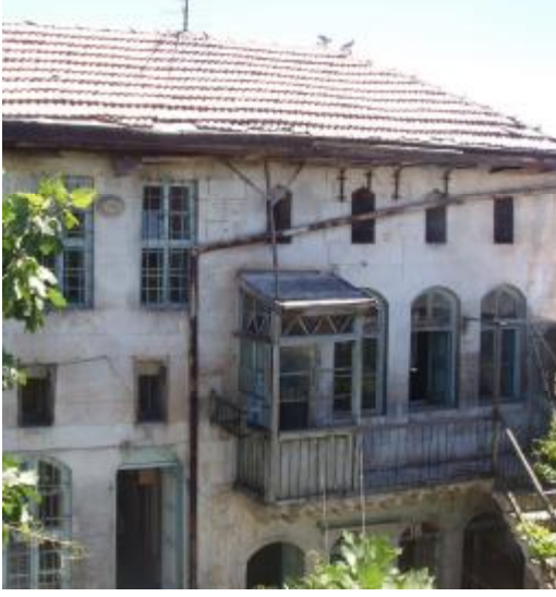
Şekil 4.18. Geçiş konsolu, 238 envanter nolu yapı
