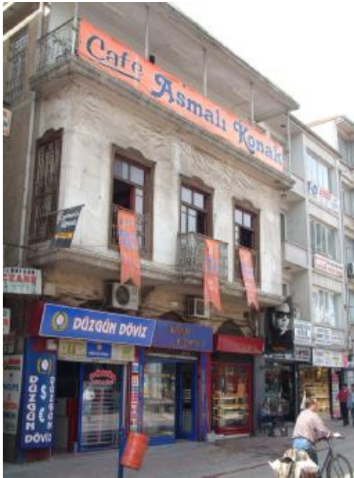
Şekil 4.200. Onarım sonrası 113 envanter nolu yapı
