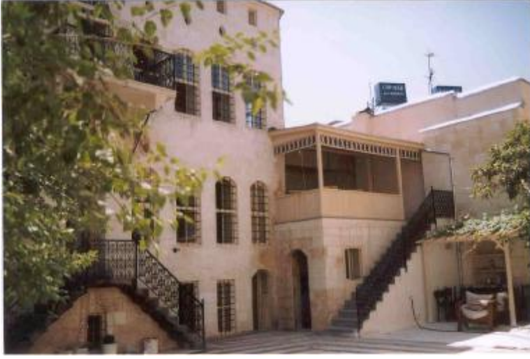
Şekil 4.107. 253 nolu yapının restorasyon sonrası
