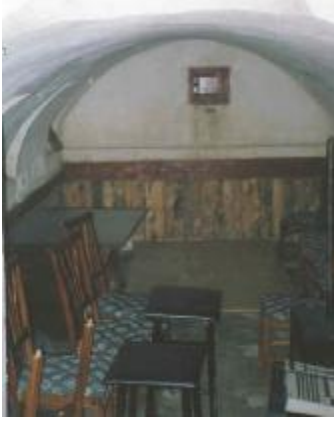
Şekil 4.148. 12 envanter nolu yapının deposu
