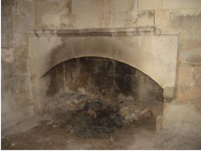
Şekil 4.61. Ocak, Dayı Ahmet Ağa Konağı, 67 envanter nolu yapı
