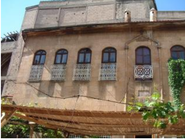
Şekil 4.125. Onarım sonrası cephe
