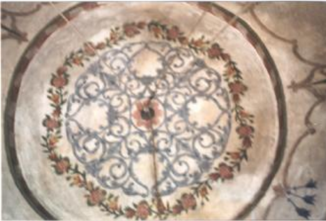
Şekil 4.39. Kubbe tavan, 232 envanter nolu yapı
