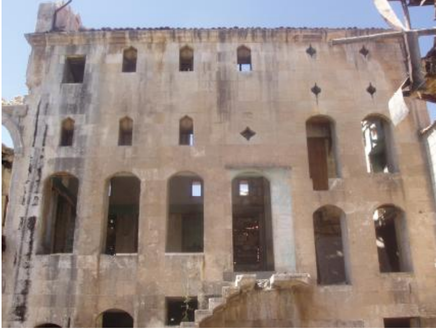
Şekil 4.24. Avlu cephesinde yer alan pencere örnekleri, 86 envanter nolu yapı
