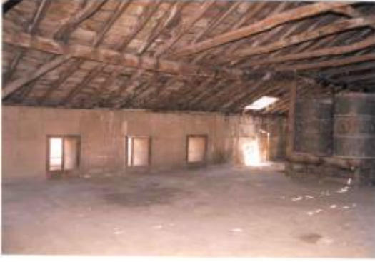
Şekil 4.11. Çatı arası, 254 envanter nolu yapı
