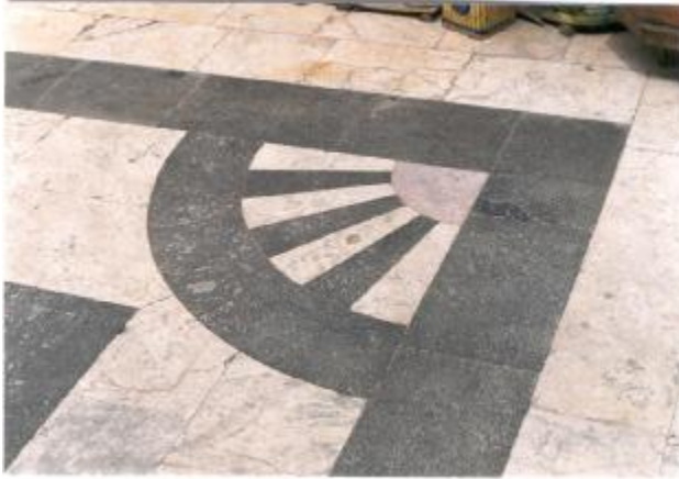
Şekil 4.10. Avlu döşemesi, 41-42 envanter nolu yapılar
