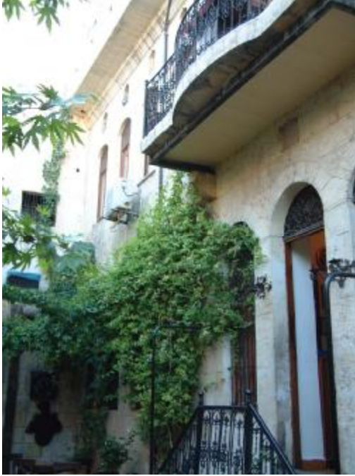
Şekil 4.209. Onarım sonrası 114 envanter
