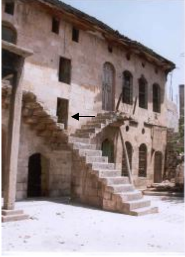
Şekil 4. 54. Haznanın dış cepheden görünümü, 267 envanter nolu yapı
