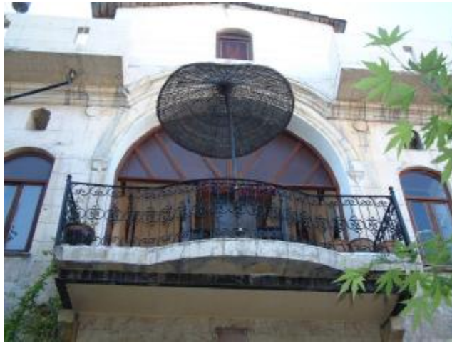
Şekil 4.211. Onarım sonrası eyvan ve balkondan görünüm
