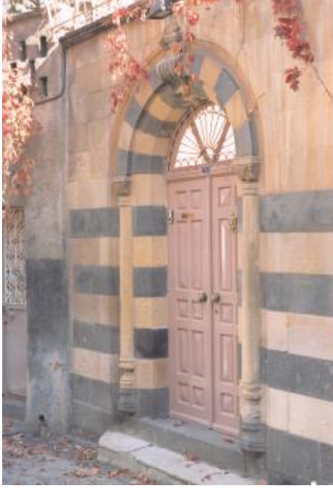
Şekil 4.19. Avlu kapısı, 16 envanter nolu yapı
