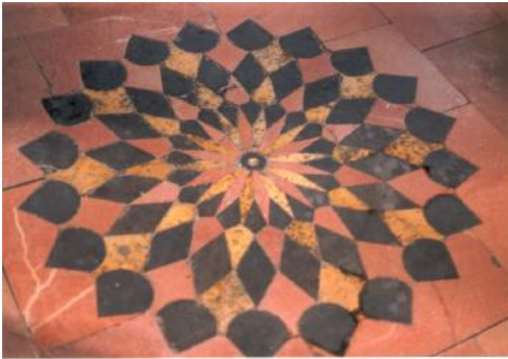
Şekil 4.5. Avlu döşemesi, 335 envanter nolu yapı
