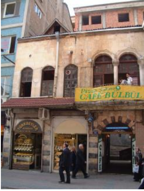
Şekil 4.187. Onarım sonrası 110 envanter nolu yapı
