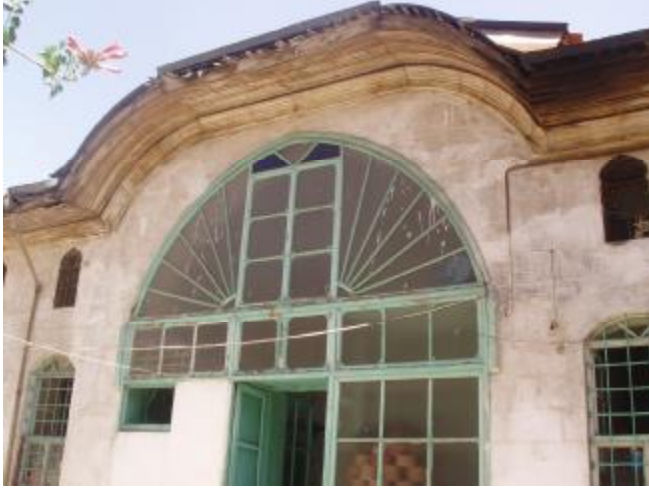
Şekil 4.69. Saçaktaki ahşap işçiliği, 38 envanter nolu yapı
