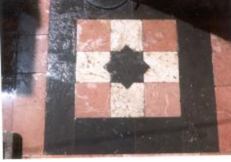
Şekil 4.47. Avlu döşemesi, 232 envanter nolu yapı
