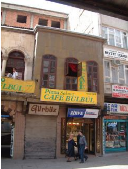
Şekil 4.188. Onarım sonrası 110 envanter nolu yapı
