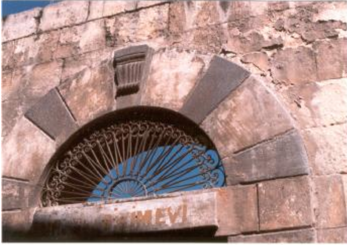
Şekil 4.20. Avlu kapısından detay, 140 envanter nolu yapı
