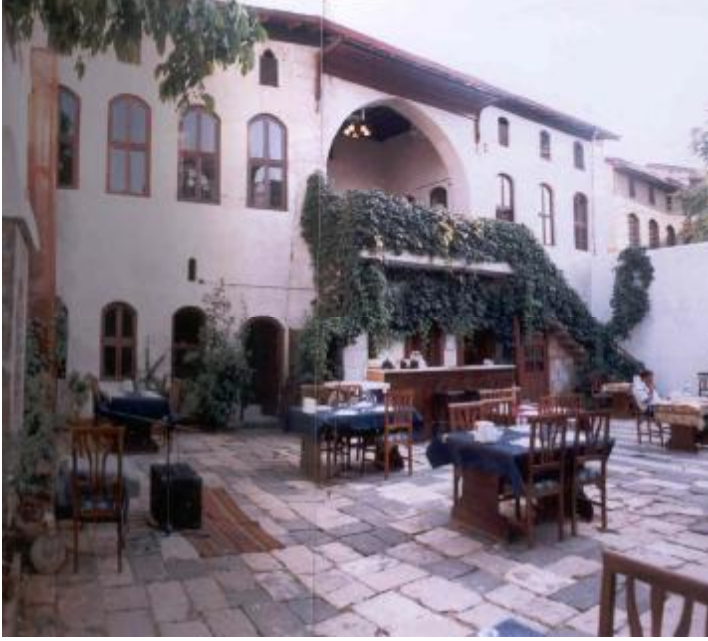
Şekil 4.150. Restorasyon sonrası 11 envanter nolu yapı
