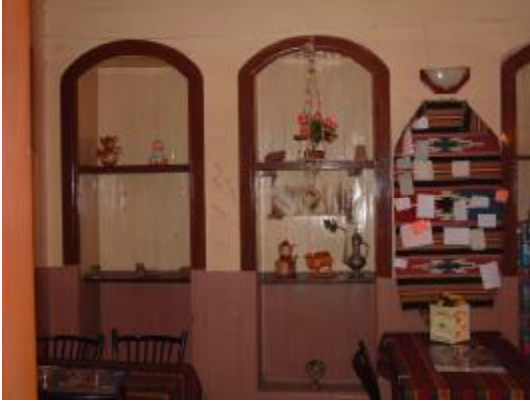
Şekil 4.192. Onarım sonrası 110 envanter nolu yapıdaki nişler
