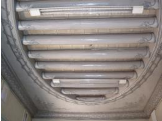
Şekil 4.34. Direkli tavan, 81 envanter nolu yapı
