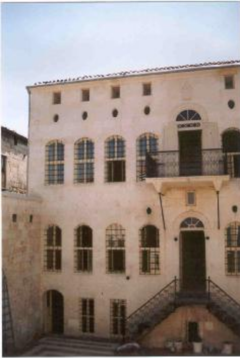
Şekil 4.106. 253 nolu yapının restorasyon sonrası
