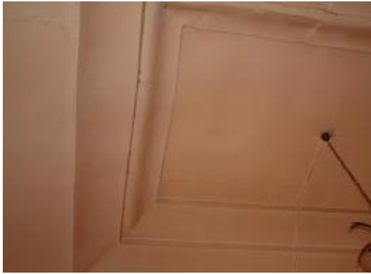
Şekil 4.191. Onarım sonrası tavan detayı
