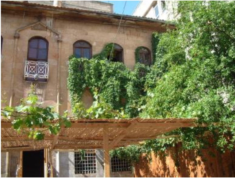
Şekil 4.124. Onarım sonrası cephe
