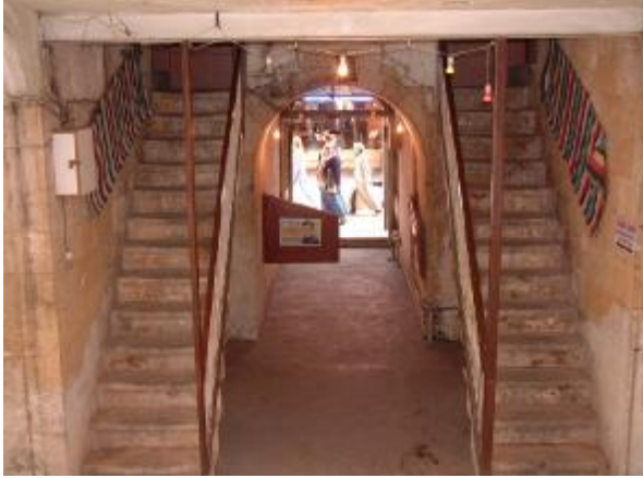
Şekil 4.190. 110 envanter nolu yapıda üst kata çıkan merdiven
