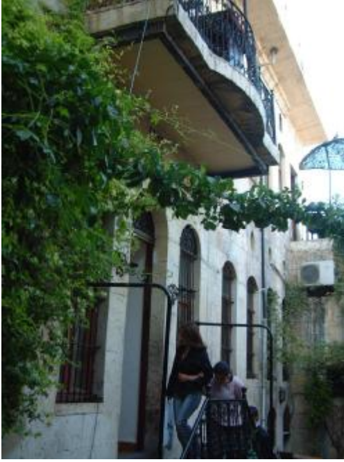
Şekil 4.210. Onarım sonrası 114 envanter
