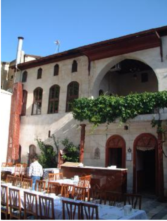
Şekil 4.159. Restorasyon sonrası 11 envanter nolu yapı
