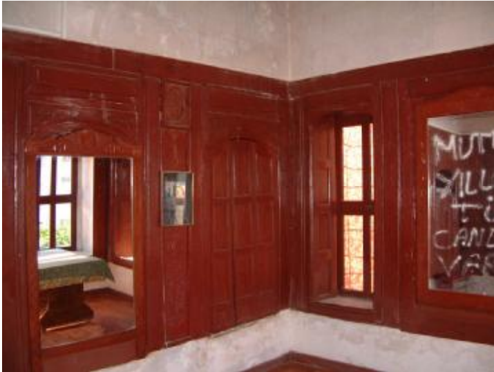
Şekil 4.160. Restorasyon sonrası 11 envanter nolu yapı
