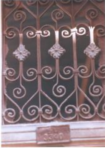
Şekil 4.45. Demir parmaklık, 232 envanter nolu yapı
