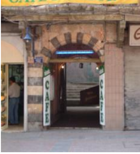
Şekil 4.189. Onarım sonrası 110 envanter nolu yapının giriş kapısı
