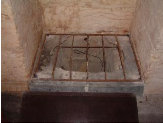
Şekil 4.49. 253 envanter nolu yapının içinde yer alan kuyu,
