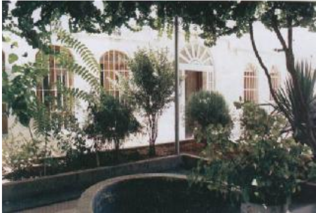
Şekil 4.46. Avlu, 81 envanter nolu yapı
