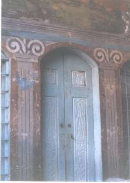
Şekil 4.41. İç kapı, 21 envanter nolu yapı
