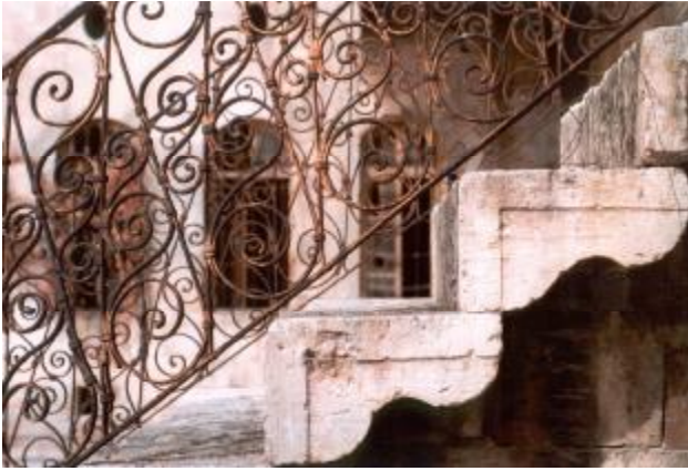
Şekil 4.44. Korkuluk, 267 envanter nolu yapı
