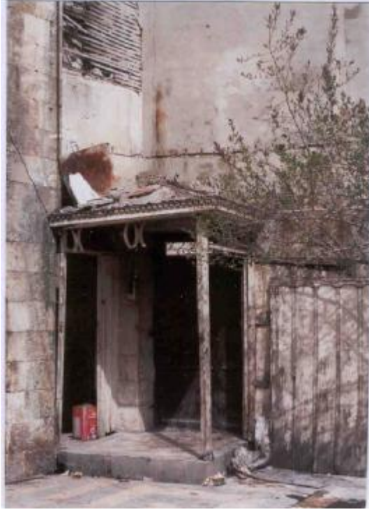
Şekil 4.89. Avlu girişi ve yanındaki wc
