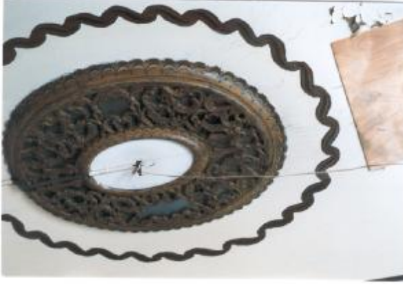
Şekil 4.70. Tavan göbeği, 141 envanter nolu yapı
