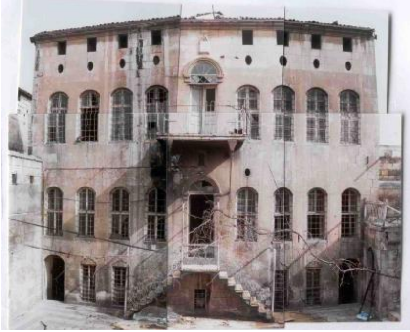
Şekil 4.76. 253 envanter nolu yapının restorasyon öncesi görünümü
