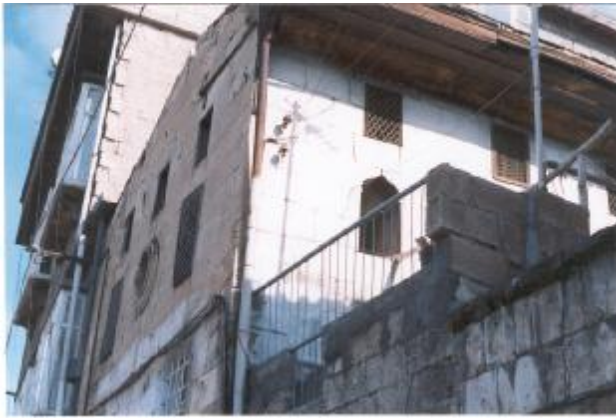
Şekil 4.32. Dikdörtgen formdaki çatı penceresi, 232 envanter nolu yapı
