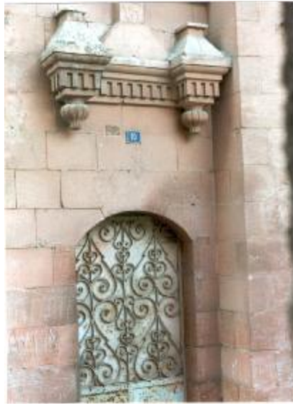
Şekil 4.21. 4 envanter nolu yapının dış kapı üstü detayı,
