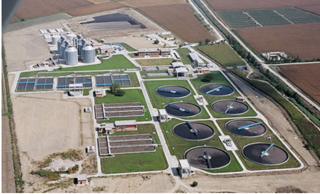
Şekil 3. 4 Adana Batı Atıksu Arıtma Tesisinin Görünüşü (ASKİ, 1999)
